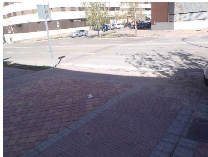
Foto 2.- Paso de peatones, sin elevar y sin bolardos.
