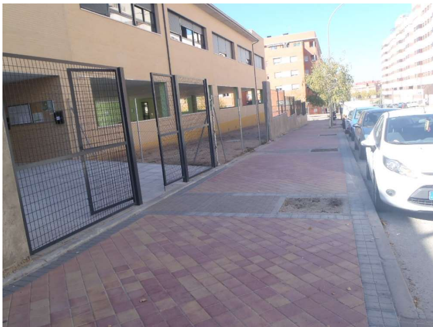
Foto 1.- Acceso al colegio, sin ampliación anchura de acera ni vallado de la misma, en C/ Puente de y.
