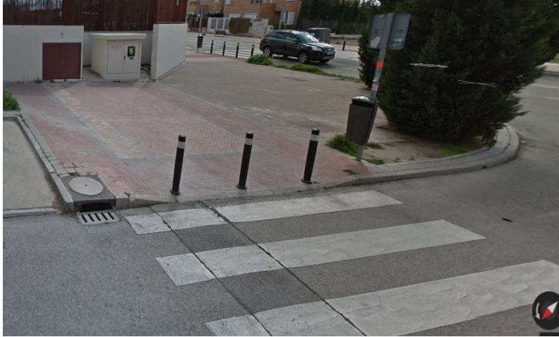
Foto 5.- Paso de peatones, sin elevar y con bolardos
