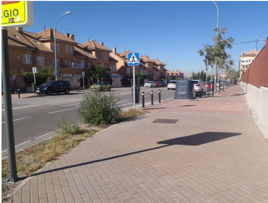
Foto 3.- Paso de peatones, sin elevar, con bolardos.
