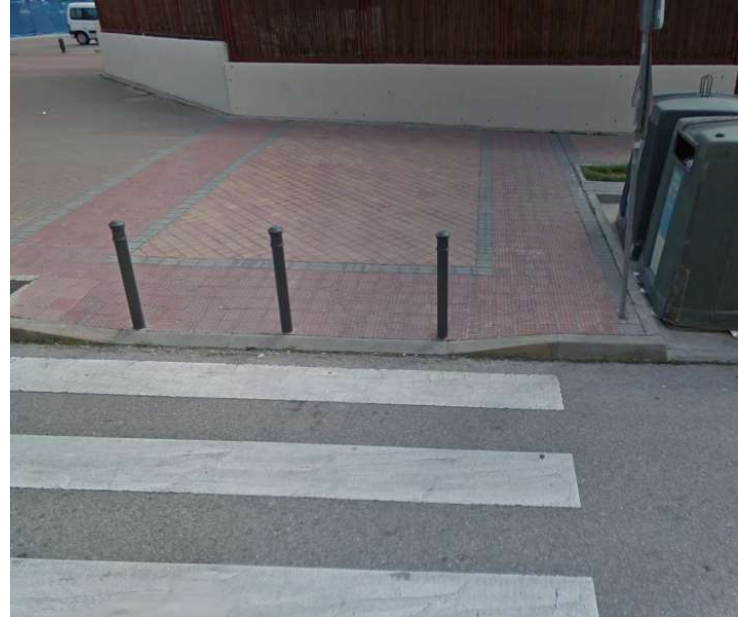
Foto 6.- Paso de peatones, sin elevar y con bolardos.
