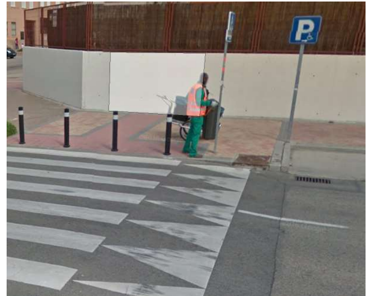
Foto 4.- Paso de peatones elevado y con bolardos.
