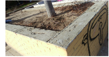
ESTADO EN EL QUE SE ENCUENTRAN LOS MURCS DELAS PLANTAS
