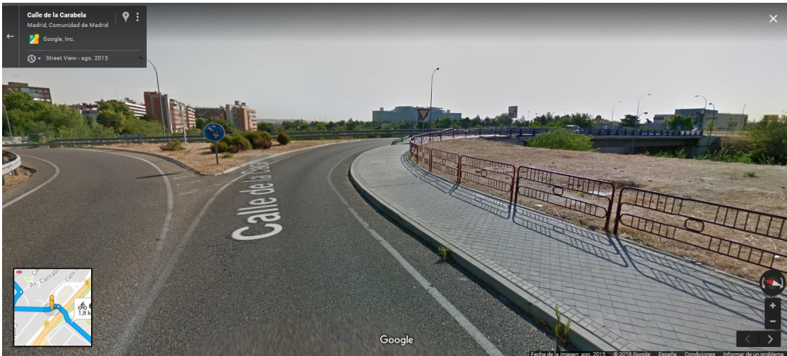
Final de la calle Carabela y acceso al puente sobre la M-14.
