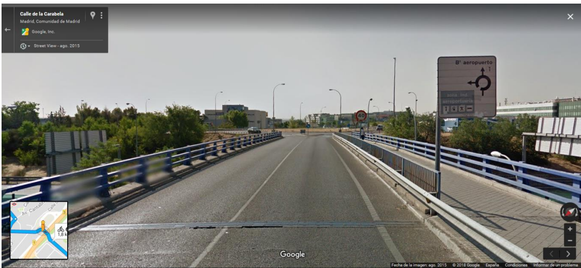
Puente sobre la M-14.
