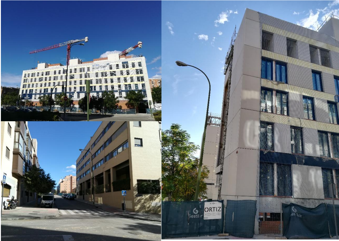
Figura 14. Edificios en construcción en la zona sur del Barrio del Pilar
