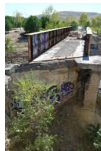
Puente en desuso
