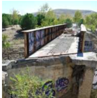
Puente sobre Cercanías
