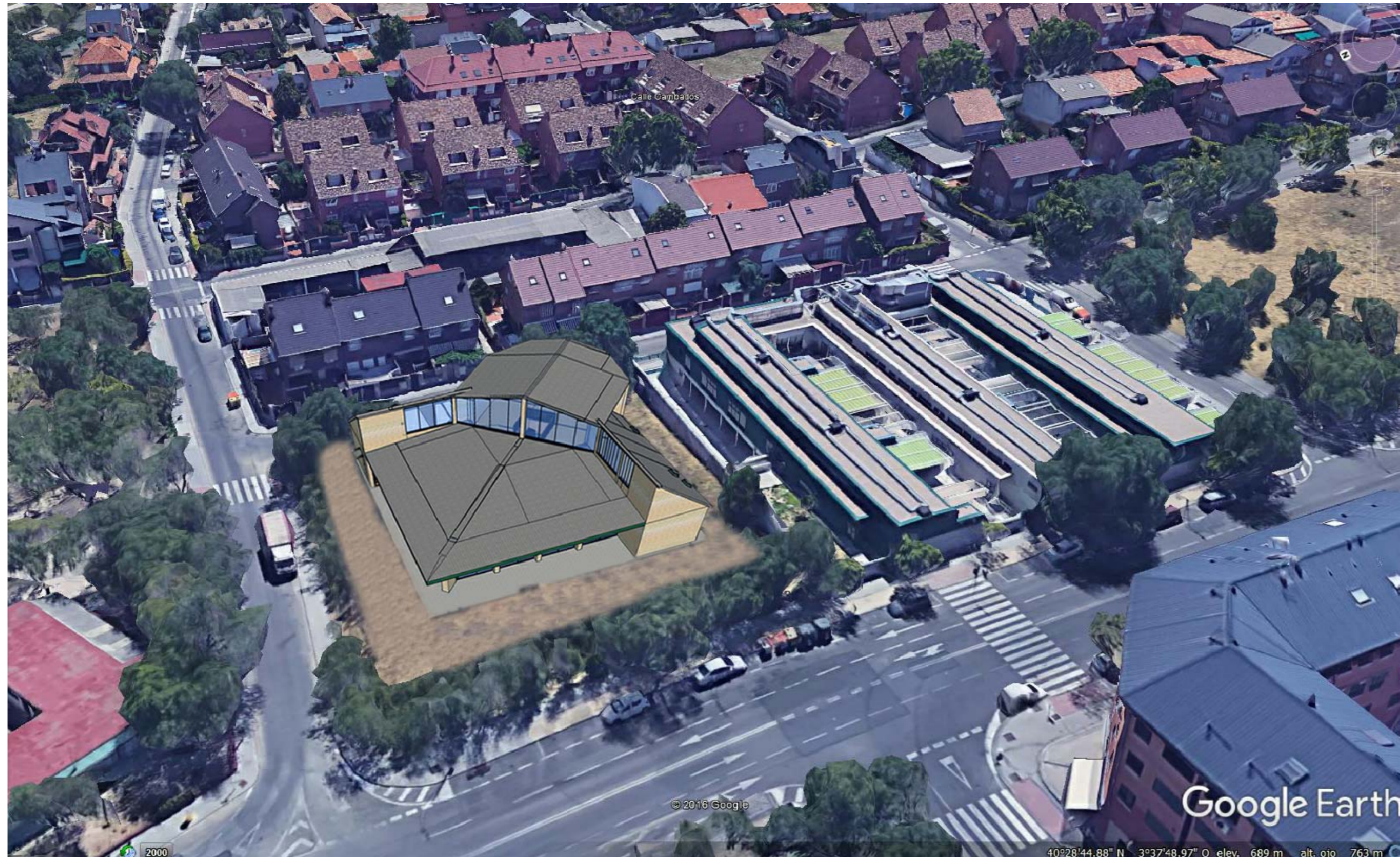
INSERCIÓN DEL EDIFICIO DEL CENTRO DE LA TERCERA EDAD EN LA PARCELA
