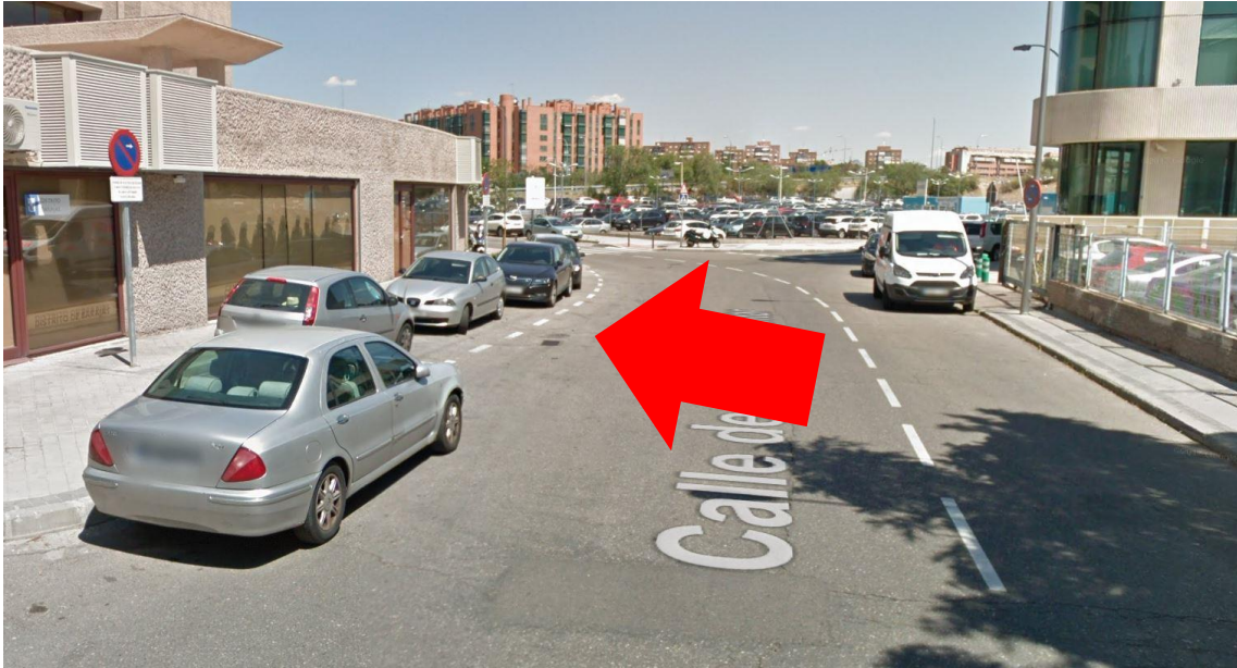
5 Ensanchar un tramo de alrededor de 30 metros de acera desplazando la banda de aparcamiento en la calle Medina de Pomar 25, frente al Centro de Mayores, creando alcorques si la anchura resultante lo permitiese.
