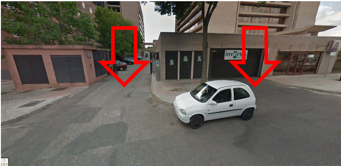
4 Modificación de los dos vados de vehículos en los accesos a la calle privada del Hotel Hilton y al aparcamiento del edificio Plaza Aeropuerto, en la calle Medina de Pomar: mantener la continuidad visual con el resto de la acera y eliminar desniveles
