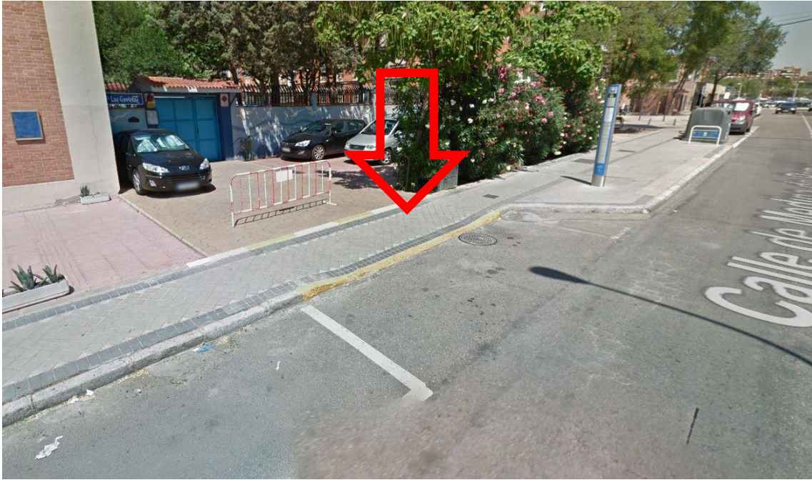
3 Modificación del vado de vehículos situado frente a la Iglesia en la calle Medina de Pomar: ampliar el ancho del vado para disminuir su pendiente.
