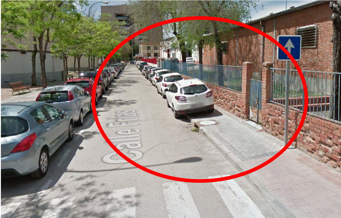
1 Instalación de bolardos en la calle Frías
