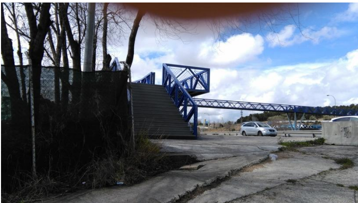
Inicio de la pasarela sobre A-3 desde P. Vallecas
