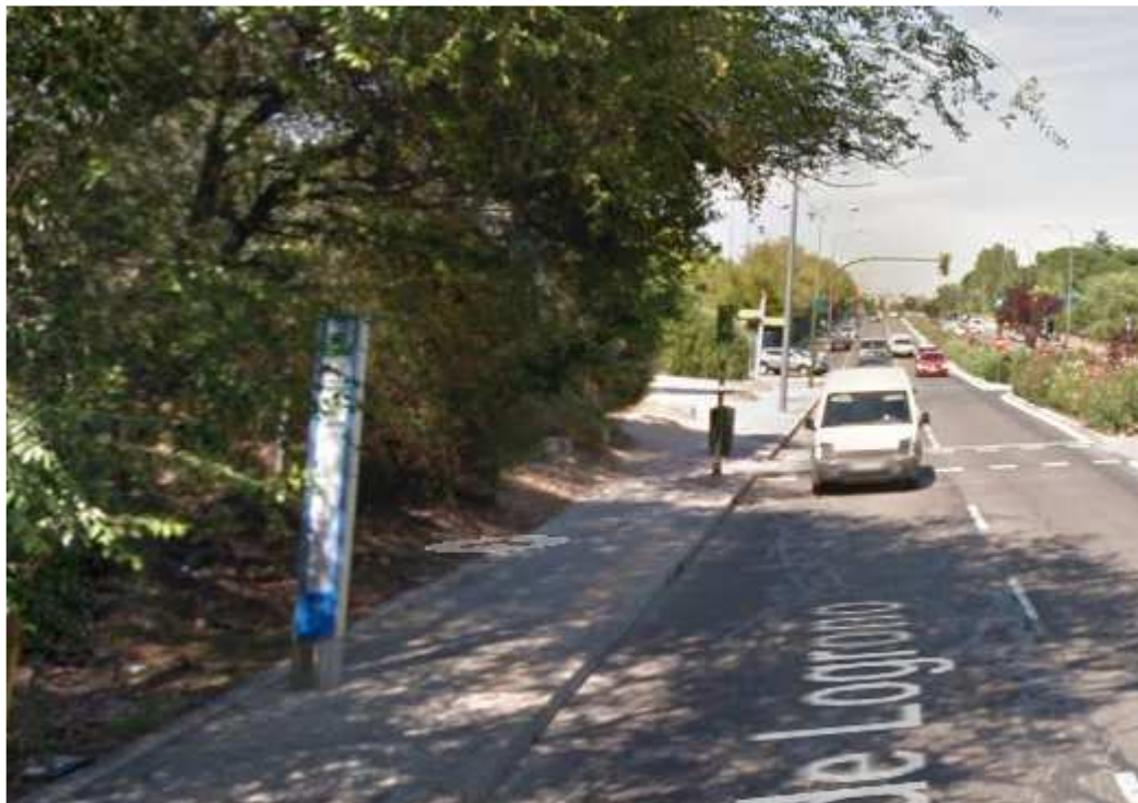
Tramo de acera entre salida del Parque y el puente, antes de la actuación
