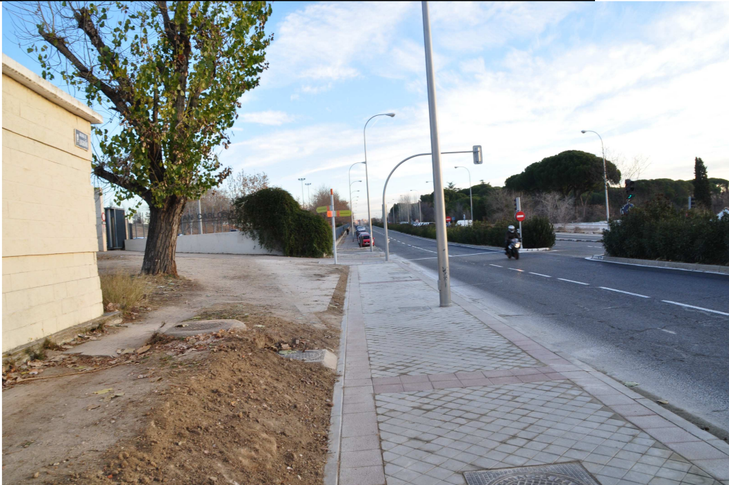
Tramo de acera entre salida del Parque y el puente, después de la actuación
