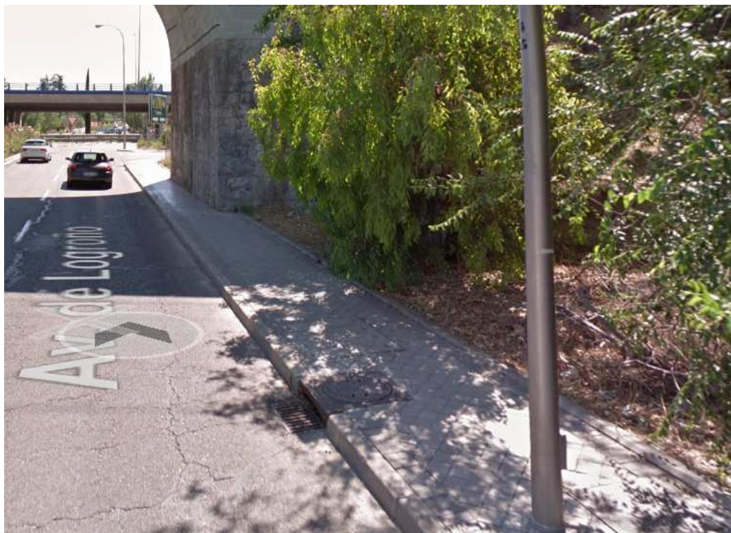
Paso bajo el puente del Ferrocarril antes de la actuación
