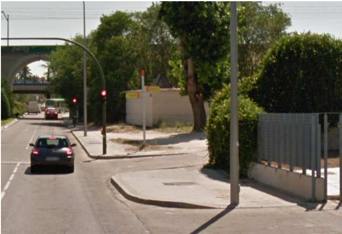
Salida del Parque Juan Carlos I antes de la actuación . Báculo de alumbrado en itinerario peatonal, pasos de peatones sin rebaje de bordillos y sin encaminamientos
