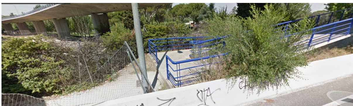
Escalón entre camino paralelo a M-605 y pasarela c/Alberca PK 0,500
