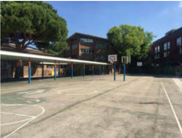
Grietas zona nº4
