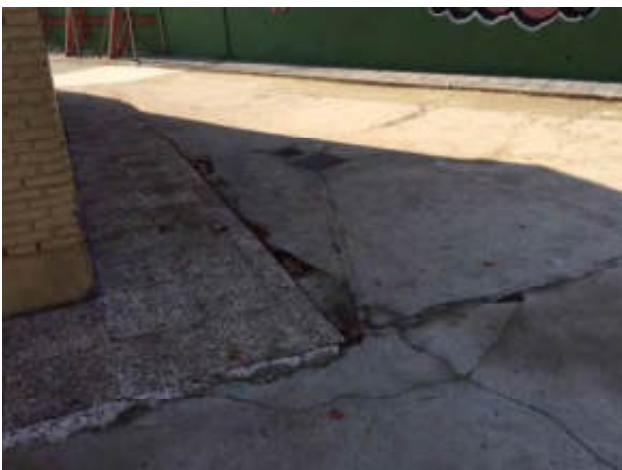
Zanja vista n°2
