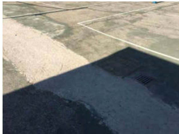
Zanja vista n°2
