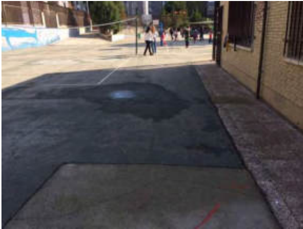
Zanja vista n°2
