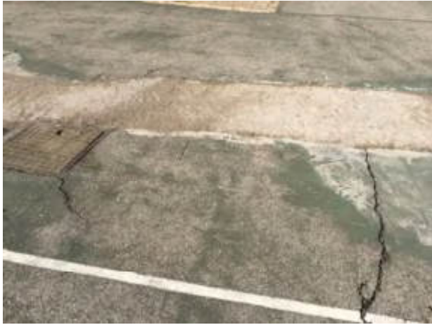
Zanja vista n°1
