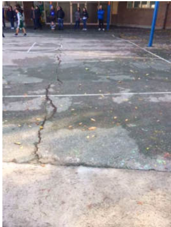
Zanja vista nº1
