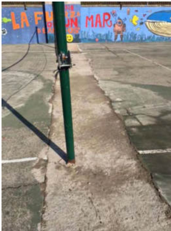
Zanja vista nº1
