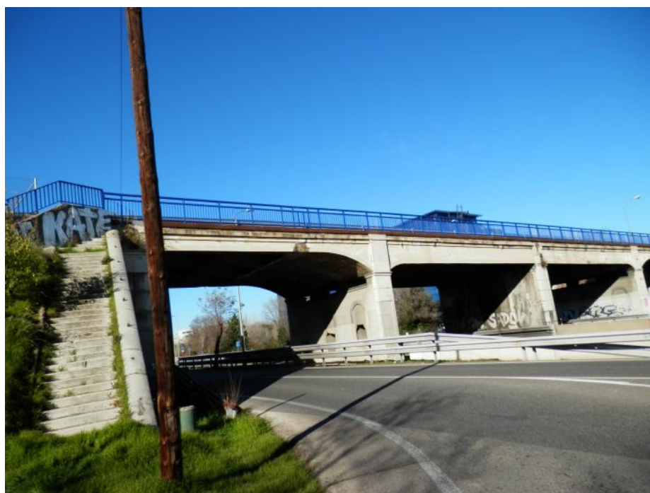
Foto 3. Lateral del puente, margen Zaragoza
