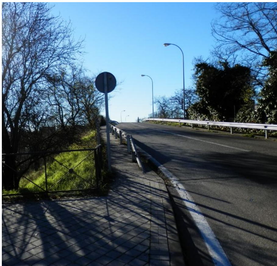
Foto 2. Arranque de la acera en la zona de La Piovera.
