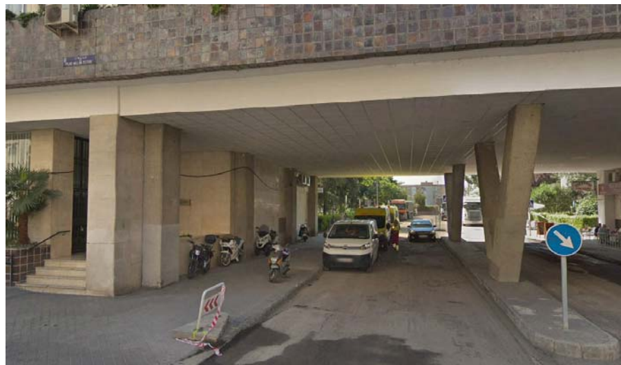
Actuacion 1B. Zona de aparcamientos publicos (SER) bajo edificio/soportal.
