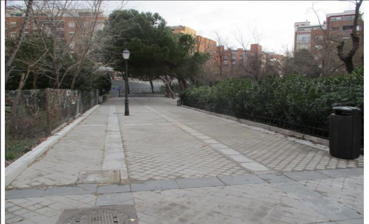
Pavimentación de loseta y tiras de baldosa granítica en pasillo lateral
