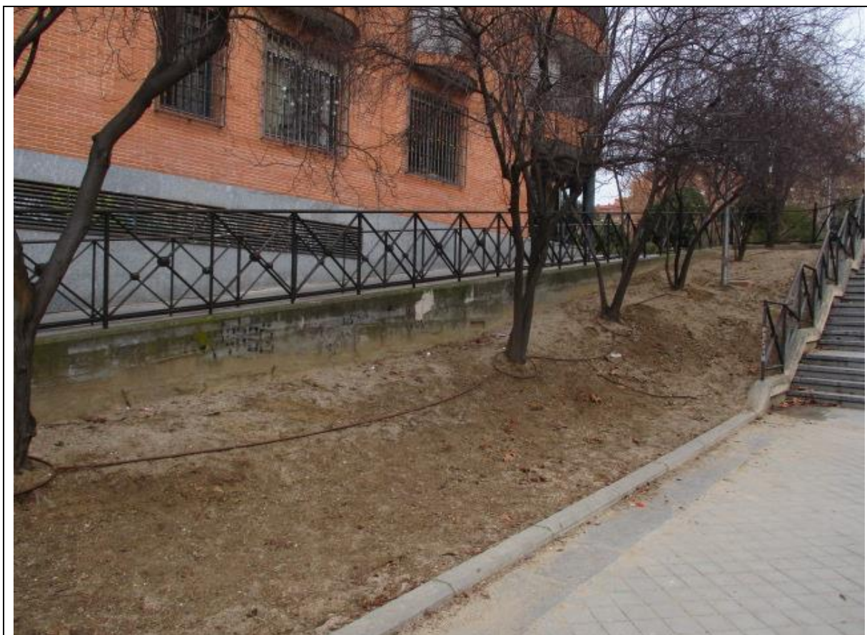
Relleno de tierra vegetal en parterre
