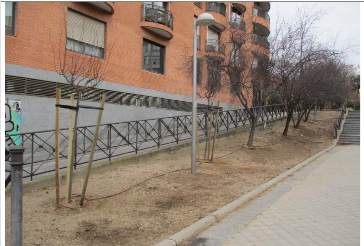
Plantación, entutorado de arbolado en tira de parterre e instalación de anillos de goteo
