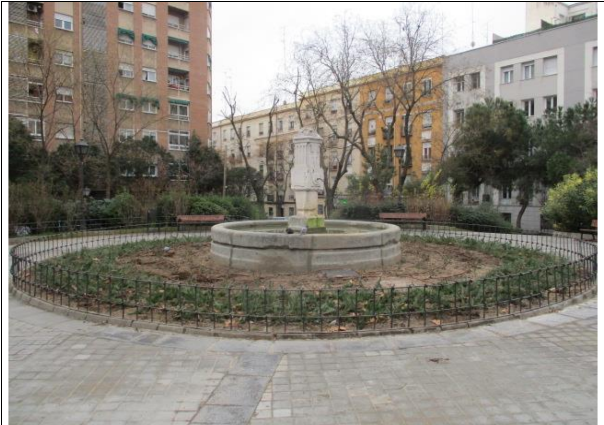
Plantación de perimetral de fuente e instalación de líneas portagoteros
