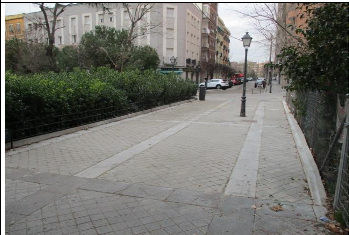
Pavimentación de loseta y tiras de baldosa granítica en pasillo lateral
