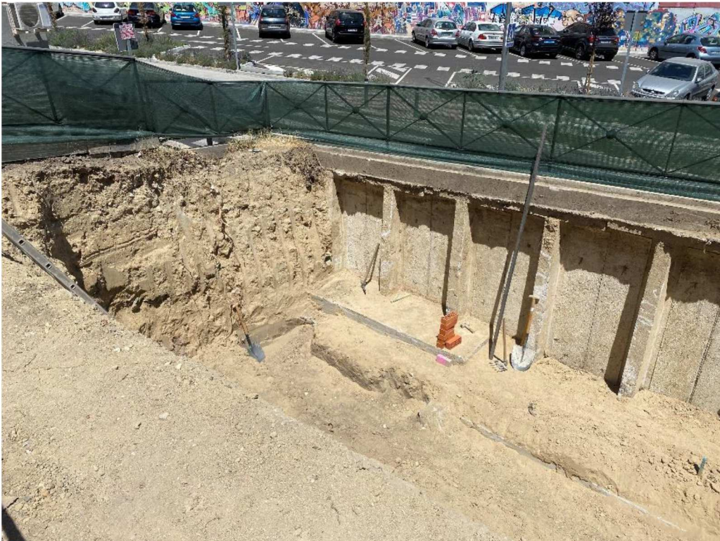
Foto 1: Excavación en la ubicación de la futura rampa
