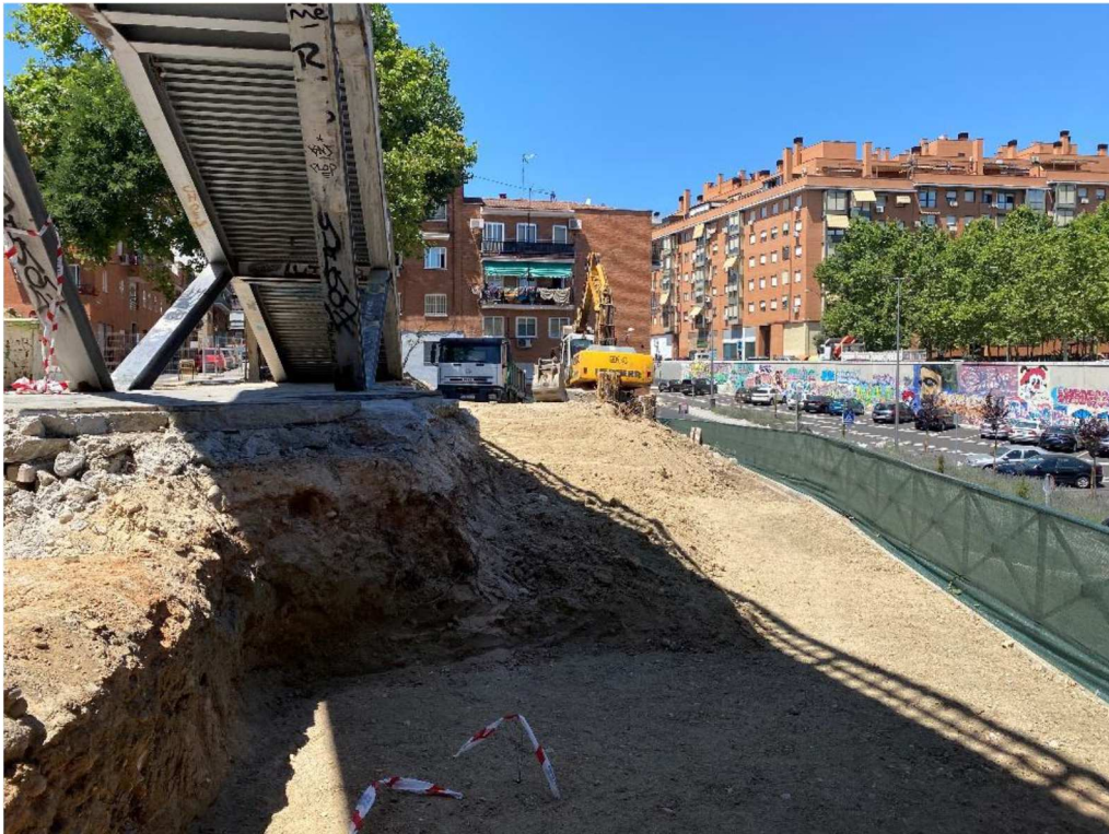
Foto 3: Excavación para la ejecución de micropilotes
