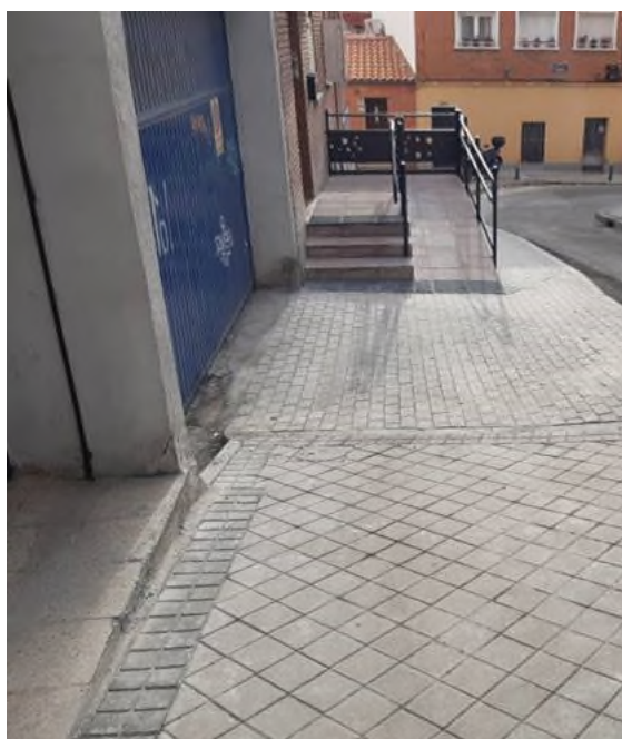
Rampa C/ Torres.
