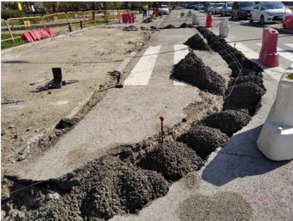
Frente C/ Beasain N.º 45: Detalle del vertido en zanja del hormigón de capa base y replanteo de la nueva alineación de bordillos.
