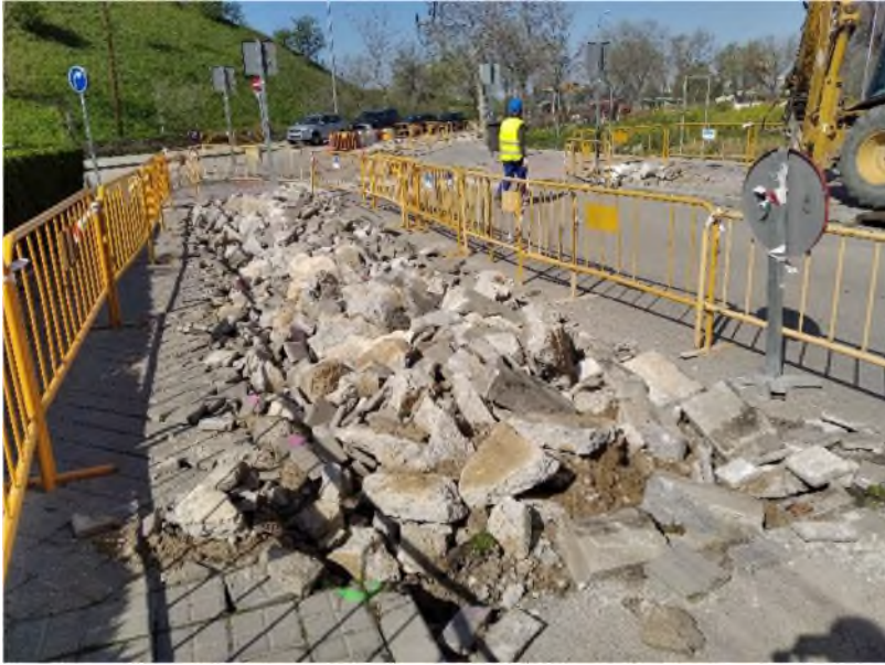
C/ Ordicia intersección C/ Gainza: Demolición parcial del pavimento asfáltico y de la actual alineación de bordillos
