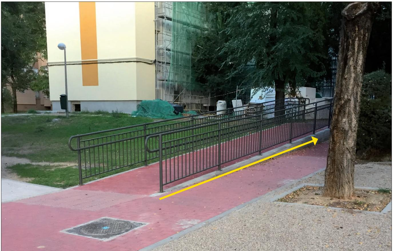
INTERBLOQUE REACONDICIONADO EN AV. DE MORATALAZ 21. Rampa de poca inclinación para sustituir escalones.
