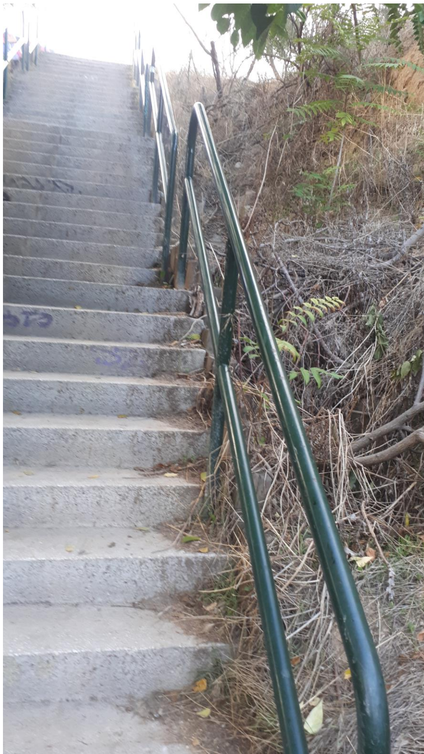
Escalera actual vista de abajo
