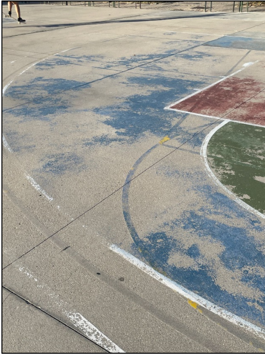
Ilustración 6: Detalle del estado del pavimento
