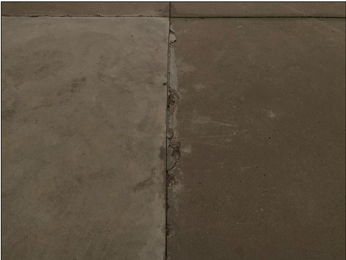
Ilustración 5: Detalle de daños en el pavimento. Zona lateral
