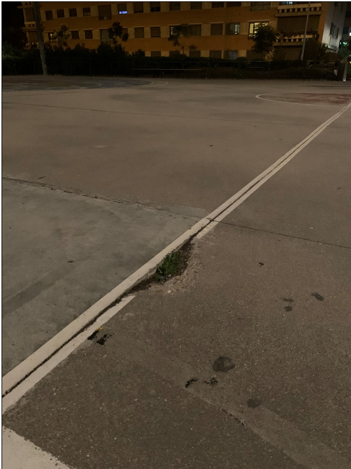
Ilustración 3: Detalle de daños en el pavimento. Zona centro de pista
