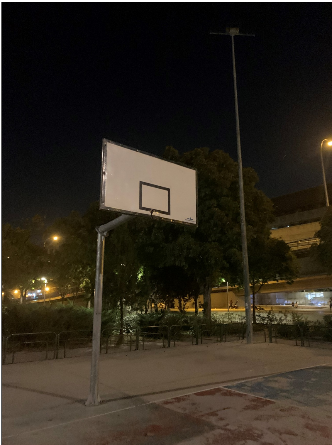
Ilustración 8:Detalle canasta con tablero dañado y sin aro. Foco fundido al fondo
