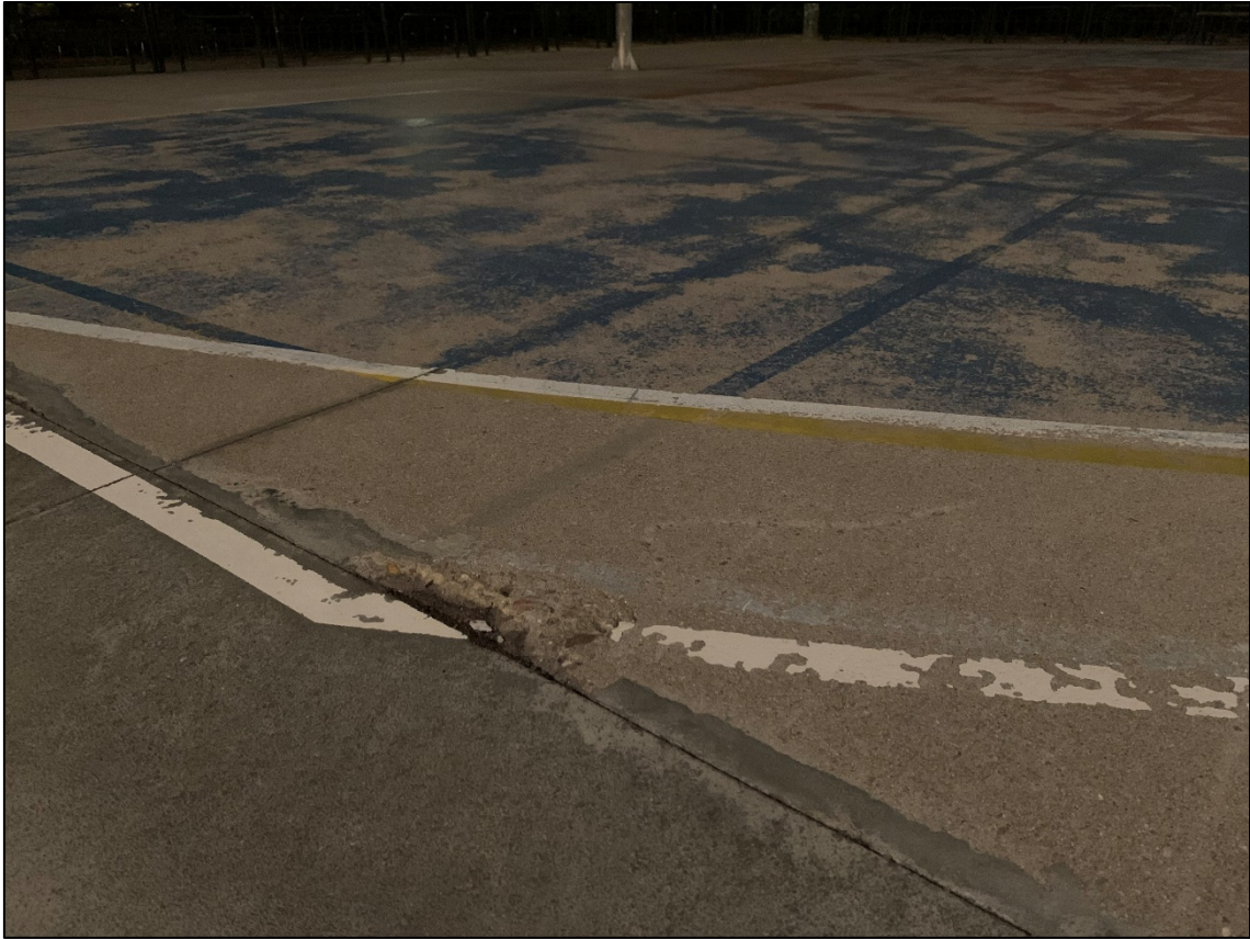
Ilustración 4:Detalle de daños en el pavimento. Zona triple
