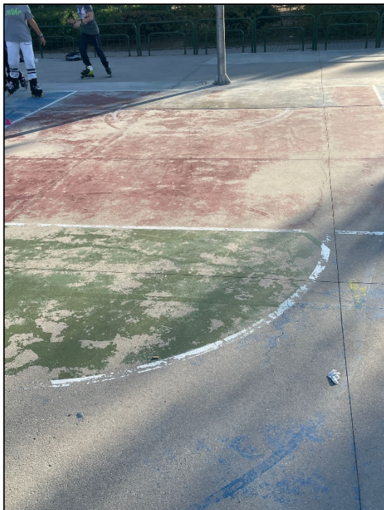
Ilustración 8: Detalle del estado del pavimento
