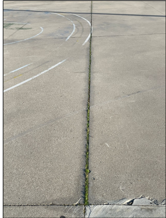
Ilustración 6: Detalle de daños del pavimento
