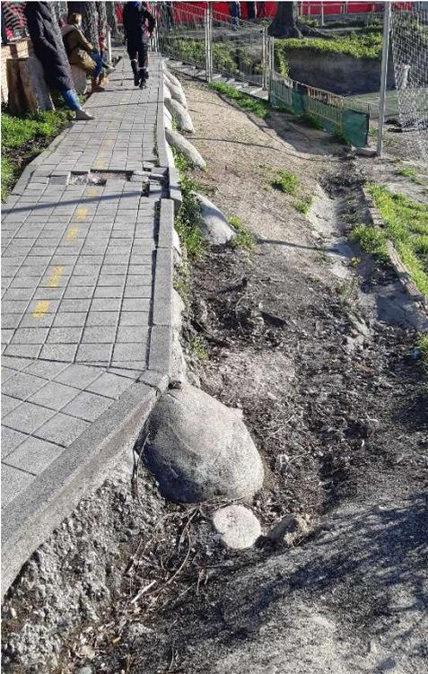
PAVIMENTO DE ACCESO MUY DETERIORADO Y TALUD EN MAL ESTADO
