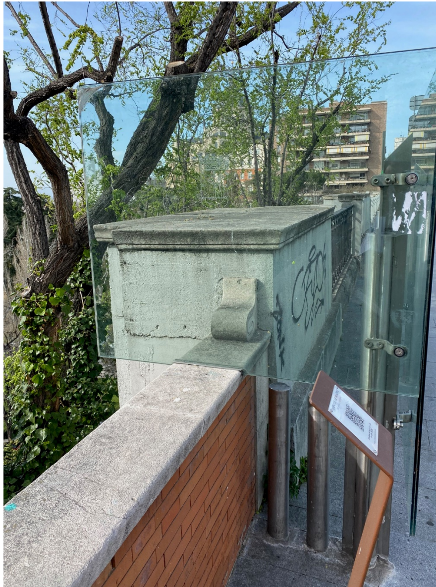
Imagen 2 – Extremo Sur del viaducto – Sistema de Protección Actual.
