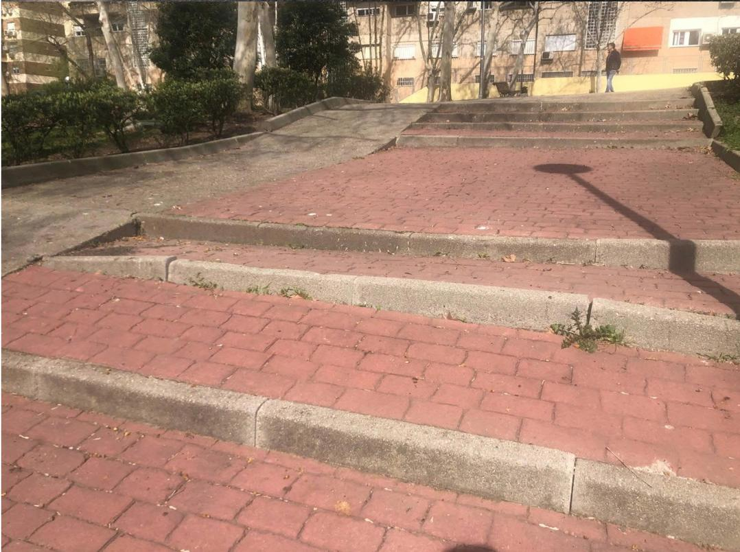
Escaleras deterioradas: bordillos hundidos, desniveles, pavimento roto
