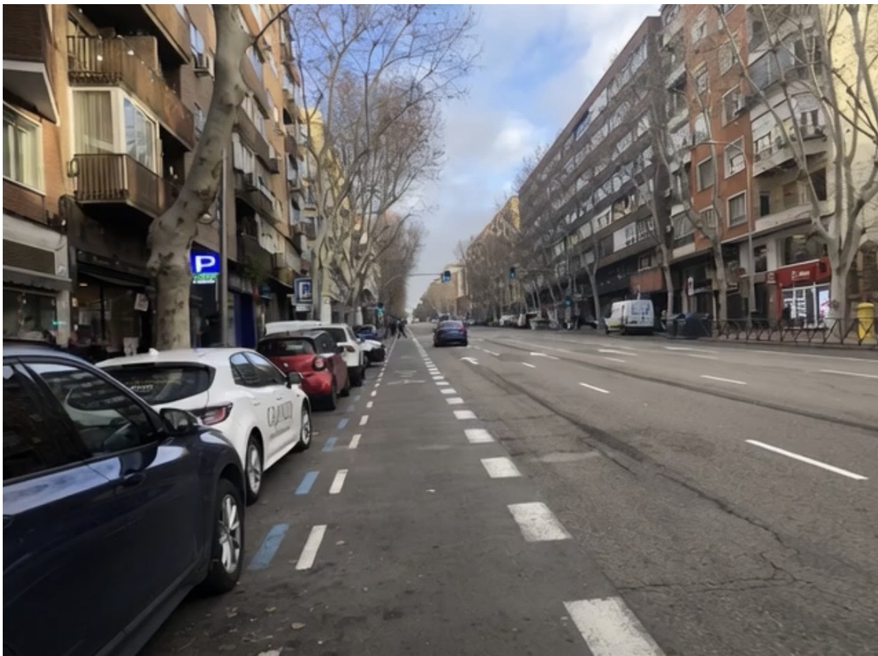
Fig. 1 — Configuración actual del carril bici en el Paseo de las Delicias. El carril discurre entre el tráfico motorizado y los vehículos estacionados, exponiendo a los ciclistas al riesgo de dooring y a maniobras bruscas hacia el carril de coches.
