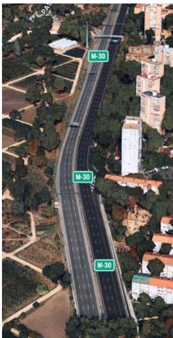
SITUACION ACTUAL Tramo de la M-30 sin soterrar
