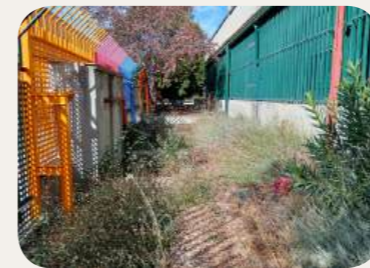
HUERTO En mal estado Falta de acceso directo
