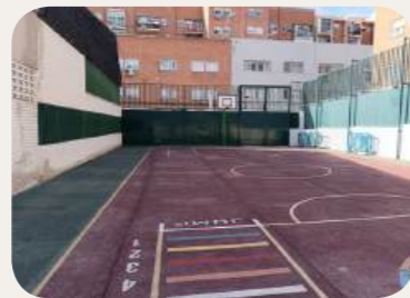
PISTA Solado hormigón, duro, no permeable. Zona calurosa. Falta de sombra
