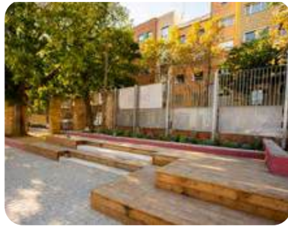
GRADAS APROVECHANDO DESNIVEL EXISTENTE
