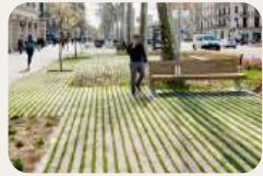
Cambio pavimento Permeable
