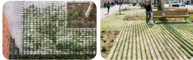
CAMBIO PAVIMENTO PERMEABLE
