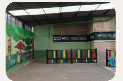
PATIO Falta de conexión entre patios
