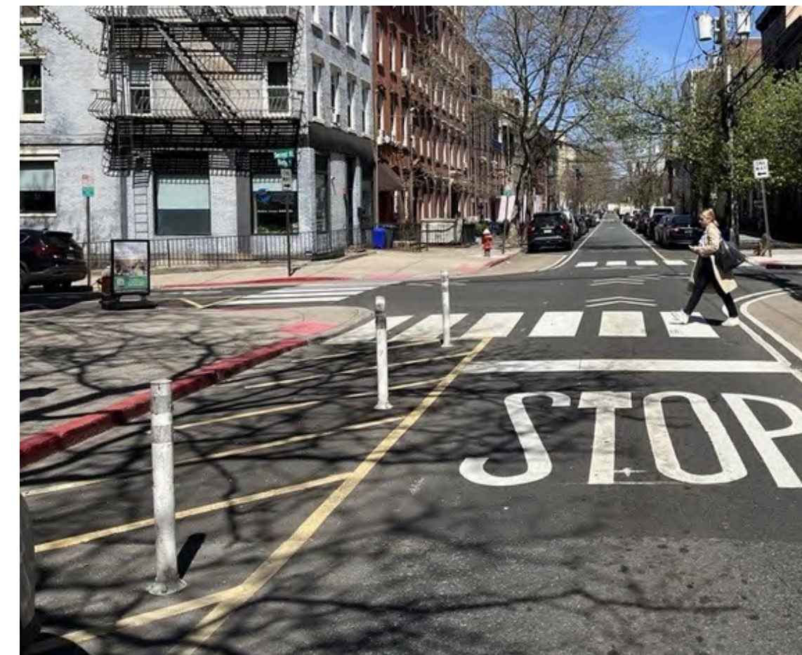
Ejemplo de una 'oreja' de bajo coste hecho con pintura y bolardos
